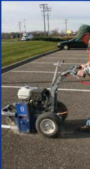
El **GrindLazer 270** es el escarificador perfecto para la eliminación de líneas de estacionamiento. Su Sistema de montaje de rueda EasyGlide hace que sea tan fácil de utilizar como un LineLazer y su diseño robusto e innovador implican que usted puede contar con que rendirá durante toda una vida de uso.
